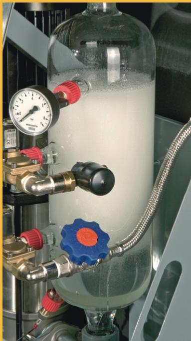
Часть теплоносителя подвергается вакууму в сосуде Spirovent Air Superior. Растворенные в жидкости газы переходят в свободное состояние, отделяются (сепарируются) и удаляются.
